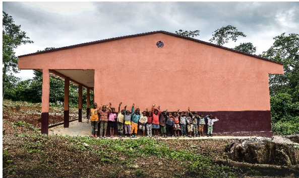
L'école d'Ebaka reçoit un nouveau bâtiment dans le cadre de l'accord de partenariat. Photo : Rodrig Mbock, 2018.
